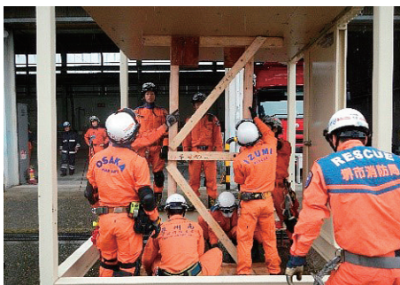
倒壊建物安定化技術
